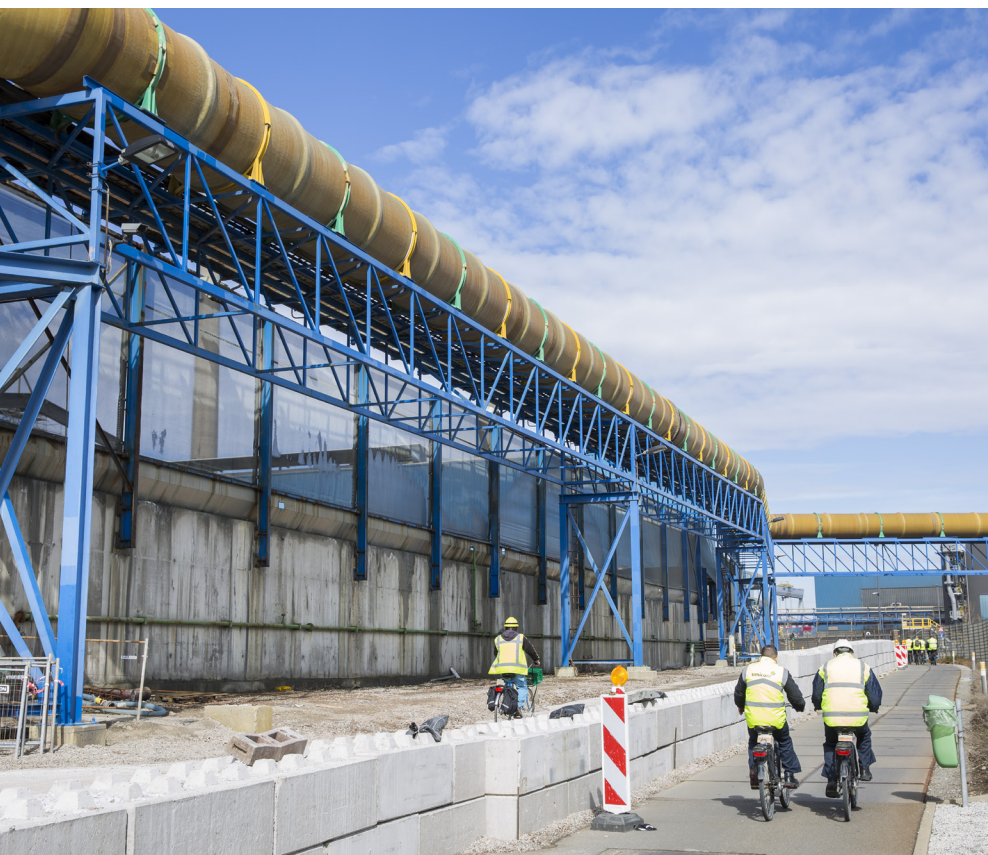
Aan het breekplein worden er hogere windschermen geplaatst.
