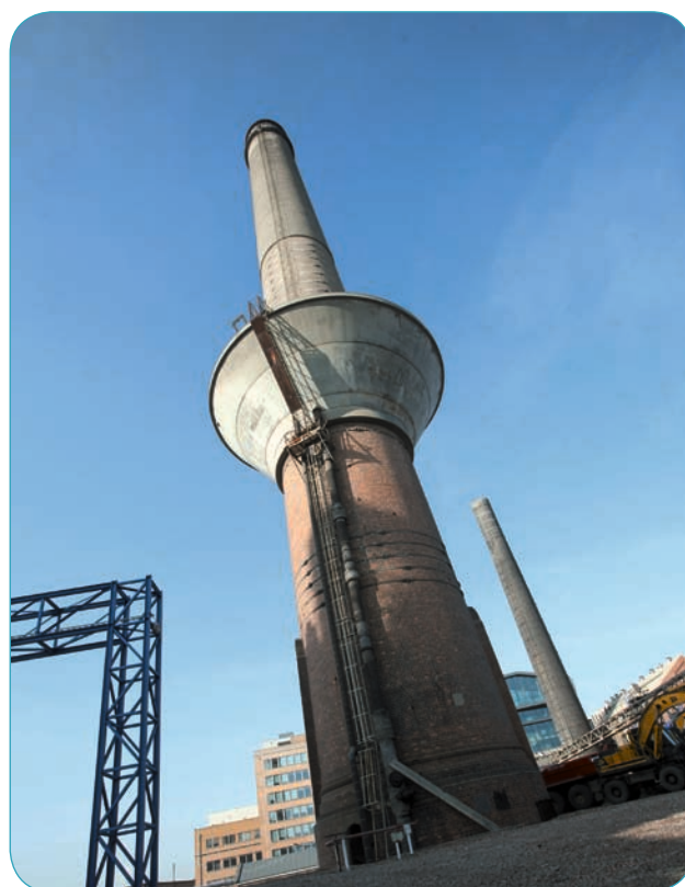
Intern gerecycleerd water wordt via deze waterbak in de fabriek verdeeld.
