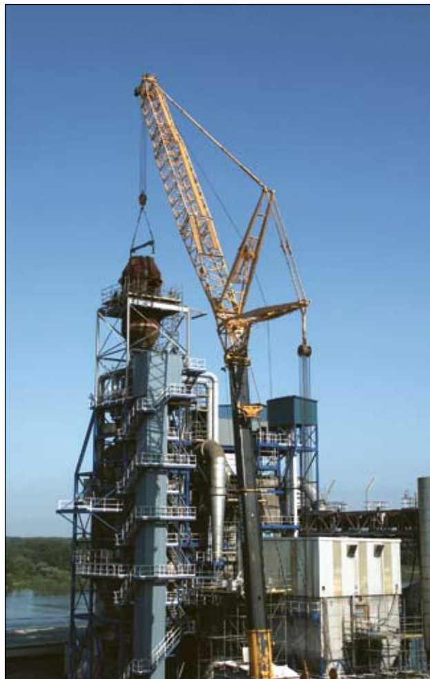
Ombouw gaszuivering van de Hoogoven
