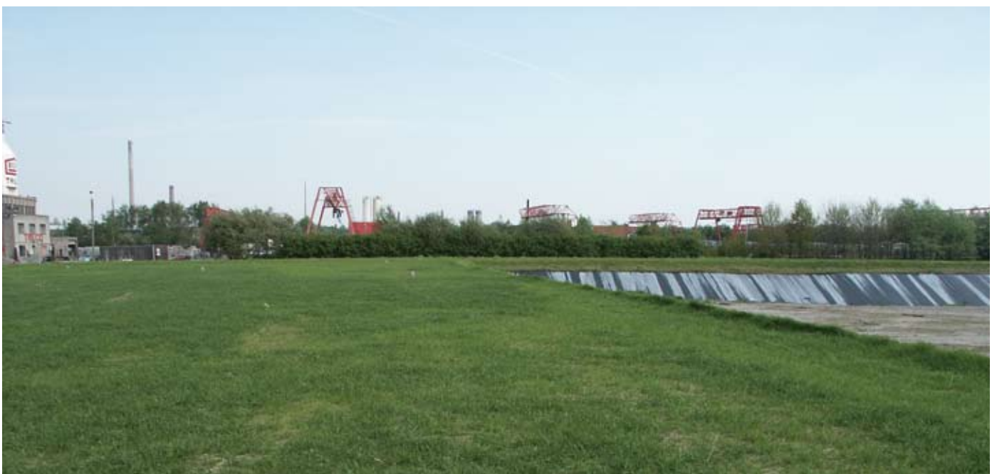
Bovenop de ondoorlatende folie werd teelaarde aangebracht die bezaaid werd met gras
