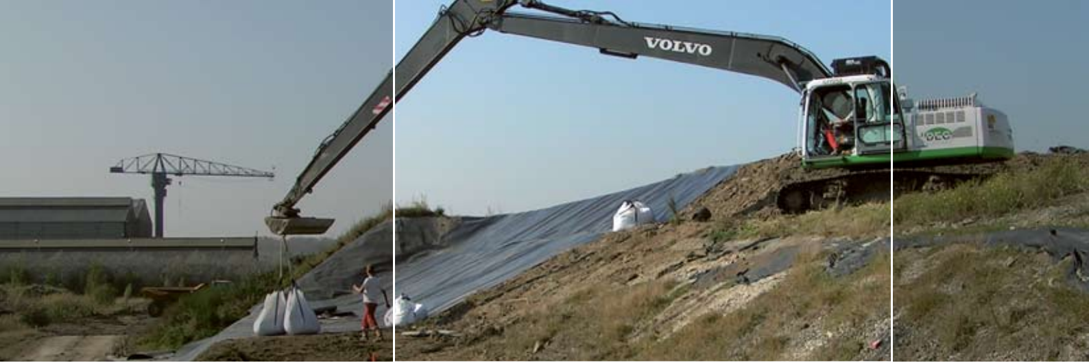
Plaatsing van de eindafdek op fase A van de stortplaats gebeurde conform de geldende wetgeving en na goedkeuring van het sluitingsplan door de bevoegde overheid.
