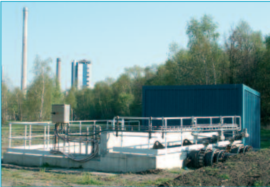
▲ Zicht op de stormpompen welke bij noodweer piekdebieten tot 7.000.000 l/u kunnen afleiden naar de Waterzuivering
