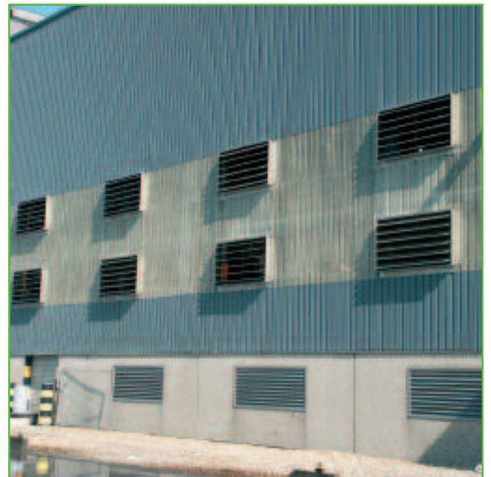
▲ Zicht op de ventilatieroosters in de gevel van de Loodraffinaderij. De investering heeft geleid tot het drastisch inperken van de emissies uit het gebouw
