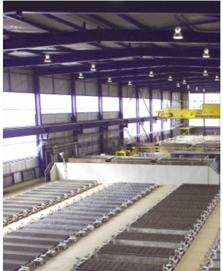
▼ | Een zicht op de cellen van de elektrowinning, met op de achtergrond de brug die de kathoden trekt.
